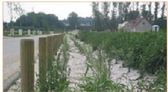
Une noue collectrice des eaux pluviales.
